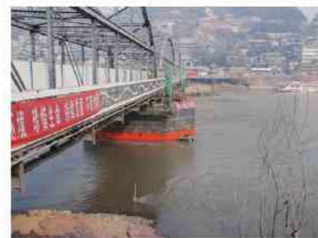
抬升加固过程
