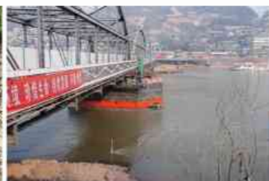
兰州中山桥顶升加固施工
