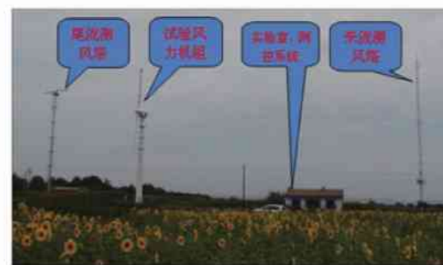
风力机空气动力学外场实验平台
