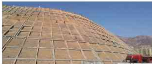
框架预应力锚杆加固边坡
