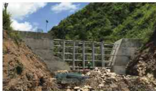
宕昌县坑沟泥石流治理钢管混凝土柱林示范工程
