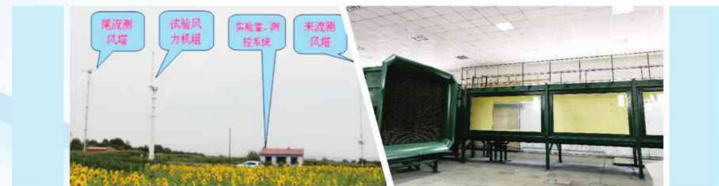
大型风力机外场基地
