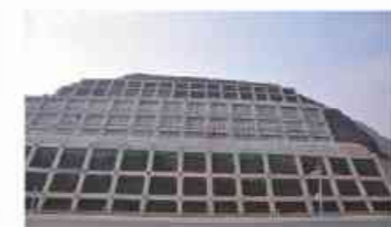
高边坡试验段施工完成
