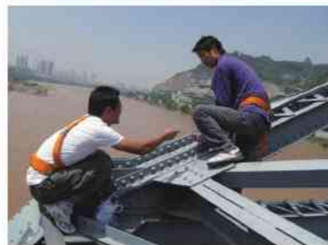
桥梁桁架节点统计
