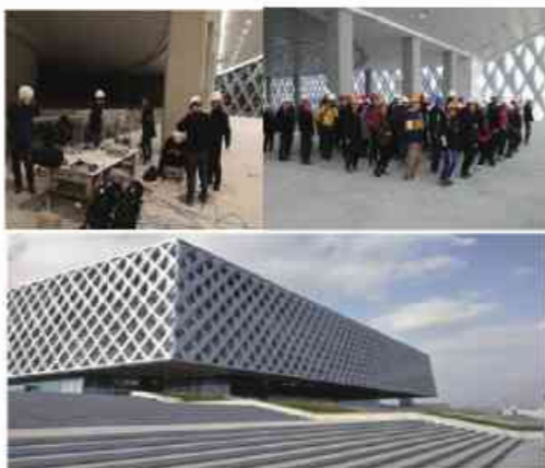
甘肃省体育馆大跨悬挑楼盖人致振动舒适度评估
