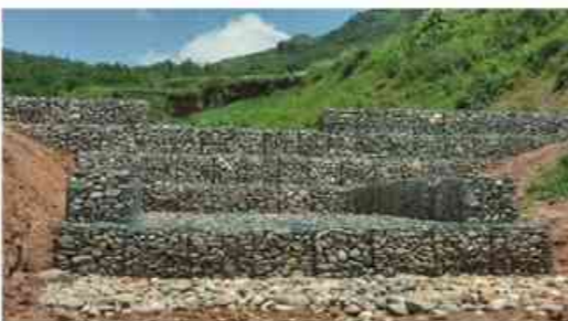
宕昌县红河沟泥石流灾害治理格宾拦挡坝工程
