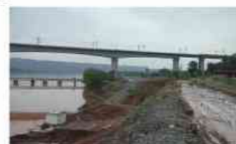
路基试验段现场
