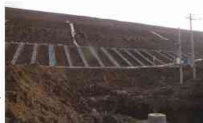
成德机场高填方边坡
