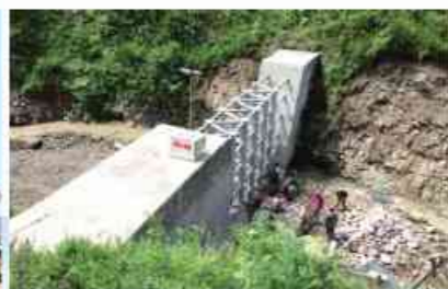
宕昌县坑沟钢管混凝土桩林挡土工程
