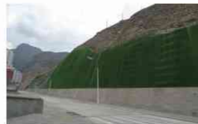
锚杆挡墙加固边坡
