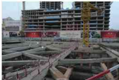
兰州地铁车站基坑
