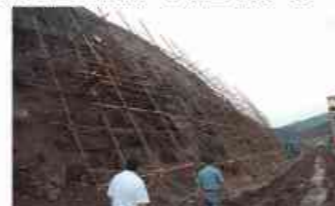
高边坡试验段现场
