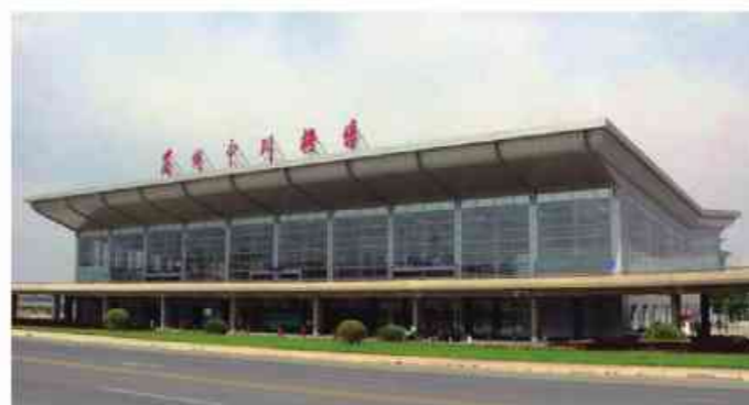
兰州中川机场航站楼钢结构屋面
